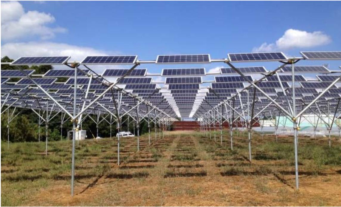
ソーラーシェアリングとは作物と電気を同時に生産する【農電併業】です。
